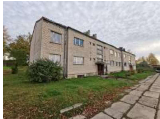
Dzīvojamā māja Stacijas ielā 7
