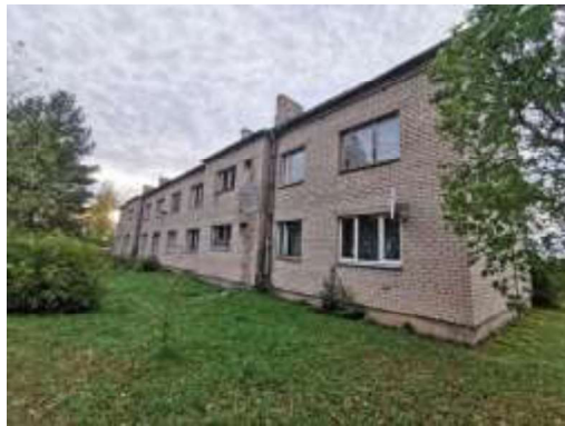
Dzīvojamā māja Stacijas ielā 7
